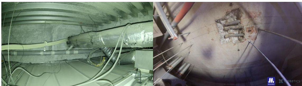
図表 6 ドローンによる駅舎天井裏点検映像
